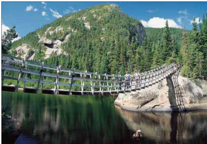
Passerelle de la rivière MacDonald dans la Réserve faunique de Port-Cartier-Sept-Îles
