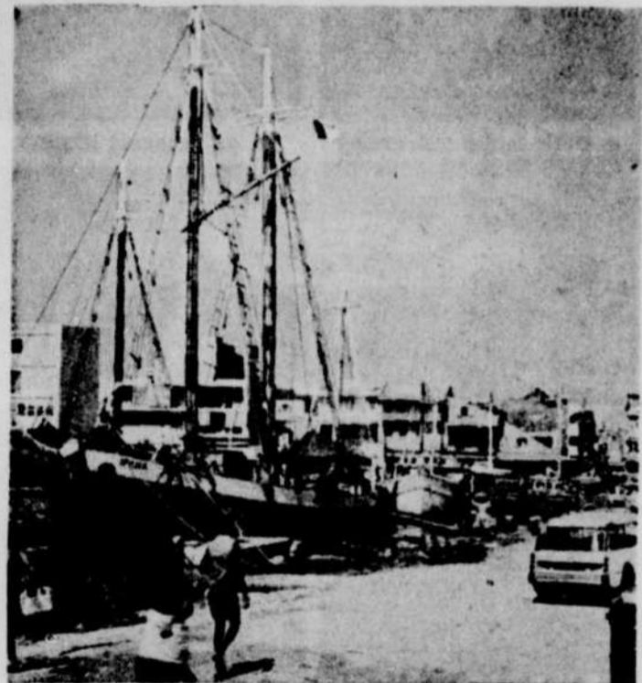
● Le qui submersible à Pointe-à-Pitre. (Guadeloupe)
