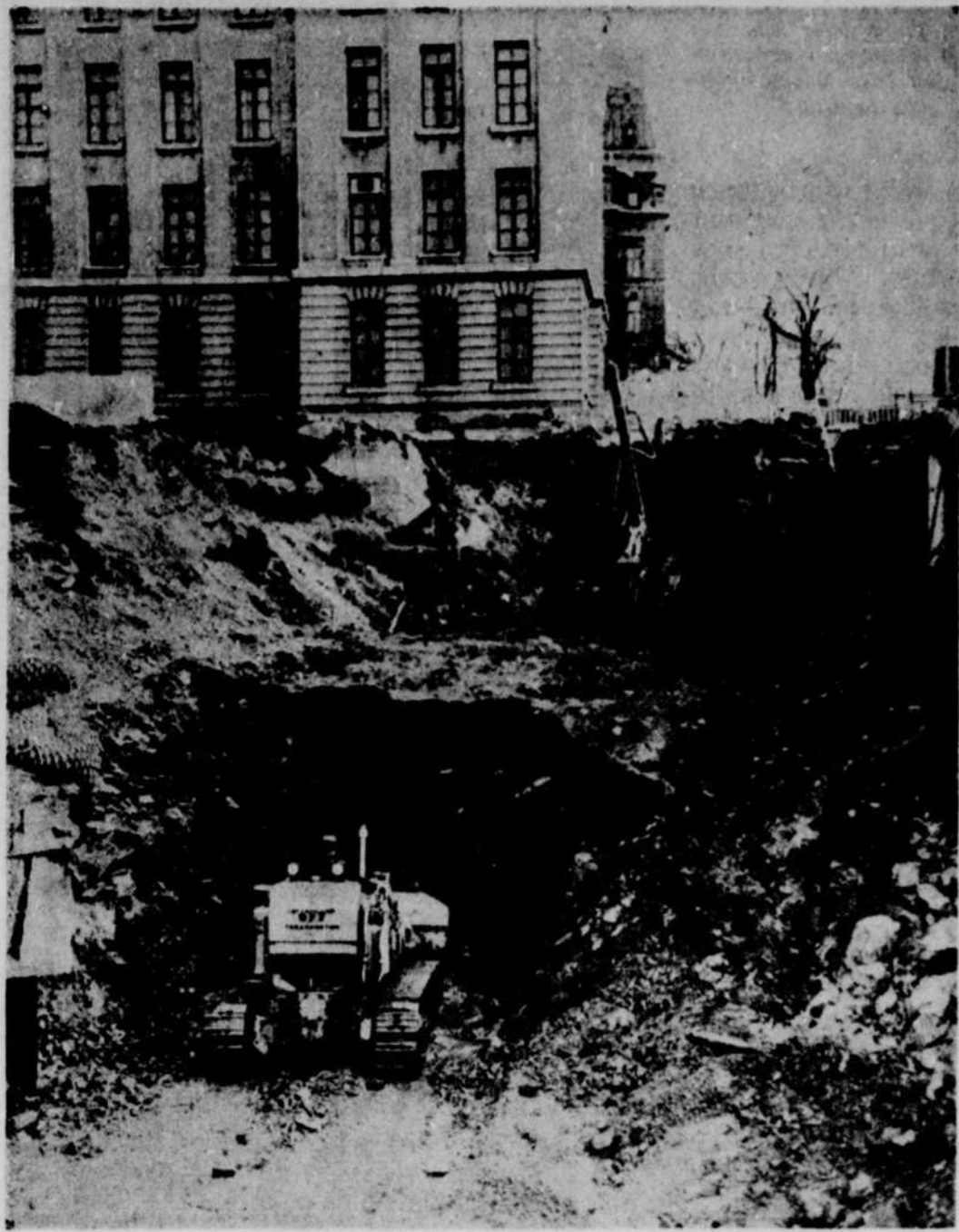
Les travaux de construction de l'autoroute Dufferin-Montmorency, ont débuté, cette semaine, près de l'Hôtel du Gouvernement, sur la colline parlementaire. Un puissant bélier mécanique a commencé le creusage de la colline, comme nous pouvons voir sur la photo ci-dessus. Comme l'on sait, cette auto-oute partira de la rue Claire-Fontaine, à l'arrière des édifices gouvernementaux, empruntera l'axe du boulevard St-Cyrille, descendra la colline dans l'axe de la rue St-Eustache pour s'élever au-dessus de la basse-ville dans le secteur du Palais et aller rejoindre le boulevard Montmorency surplombant les cours de triage du Canadien Pacifique et du Canadien National.
