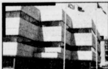
• Edifice Ray-Bourg, Charlesbourg
