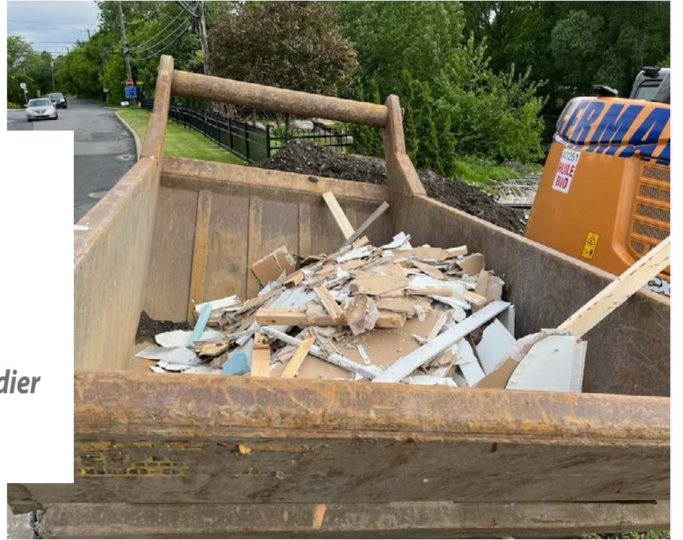
Les employés de la compagnie d'aménagement paysager ont dû disposer des matériaux dans un site approprié. (Photo : courtoisie)
