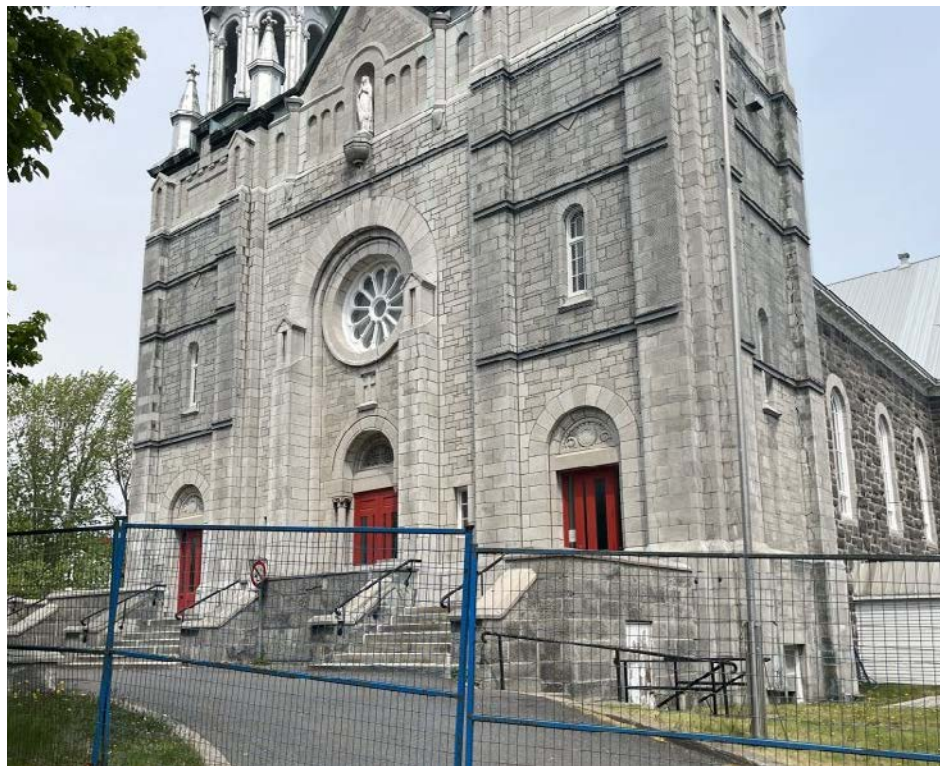
Des travaux de réfection sont nécessaires à l'église de Marieville. (Photo : archives)
