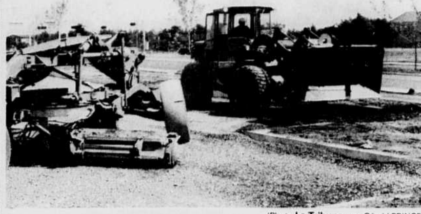
Plusieurs machines s'activent à la finition des terrains de stationnement.
