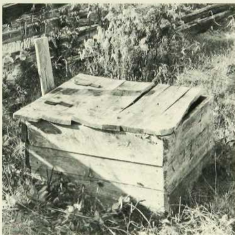
Caisse du puits, il faut noter ici la présence de pentures de cuir, la planche clouée verticalement sert à égoutter le seau et retient le couvercle lorsque le puits est ouvert. Près de cette caisse on trouve ordinairement une auge ou un demi-baril rempli d'eau pour permettre aux animaux de boire.
