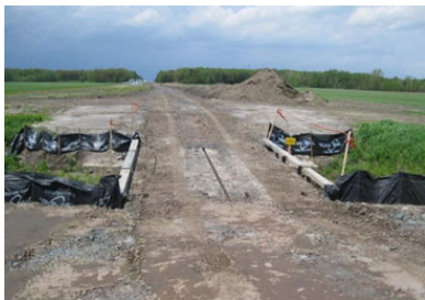
Photo B.5 : Pont provisoire avec barrières à sédiments
