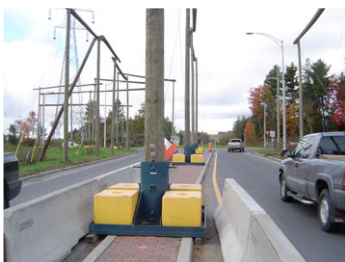
Photo H.1 : Portiques de bois installés pour maintenir la circulation lors du déroulage des conducteurs
