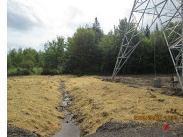
Photo F.3 : Protection des sols par ensemencement et mise en place de paille
