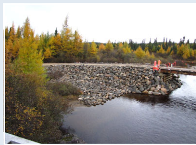
Photo B.3 : Stabilisation par enrochement
