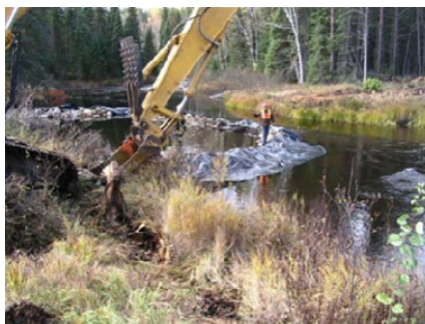
Photo B.7 : Construction d'un atardeau en enrochement
