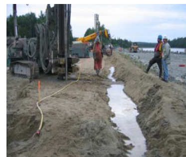
Photo F.16 : Fossé de rétention
