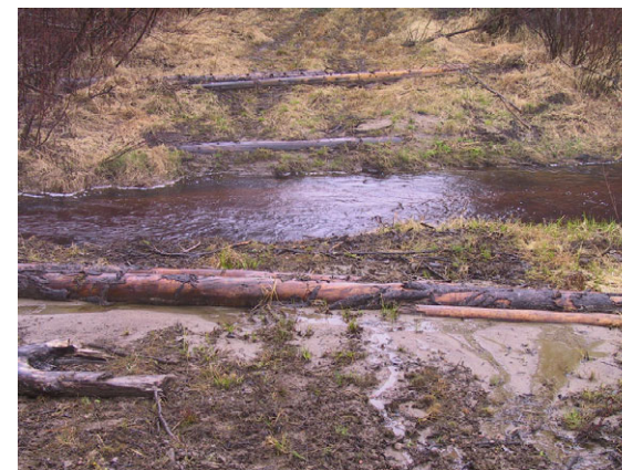
Photo B.11 : Billes de bois laissées en place à la suite du retrait d'un pont provisoire, projet de la ligne Chute-Allard-Rapide-Blanc
