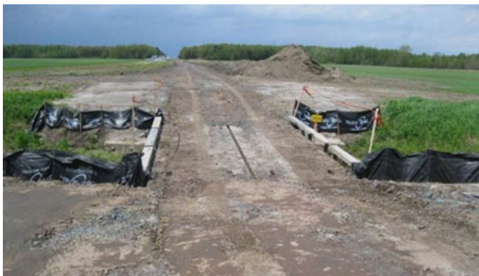
Photo F.11 : Barrière à sédiments avec géotextile installée de part et d'autre d'un pont provisoire
