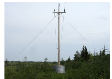
Photo A.14 : Utilisation d'un caisson métallique autour d'un poteau de bois
