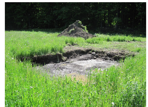
Photo D.4 : Aménagement d'une aire d'entreposage, projet de la ligne Nicolet-Bécancour
