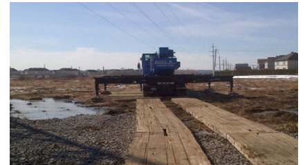
Photo A.13 : Grue en opération sur des matelas de bois
