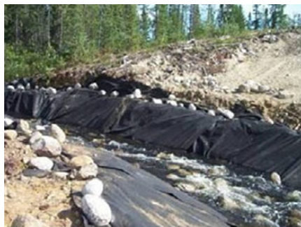
Photo B.8 : Canal de dérivation des eaux
