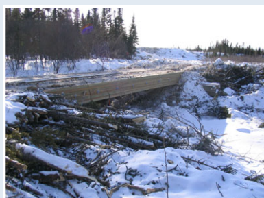
Photo B.4 : Stabilisation à l'aide de fascines
