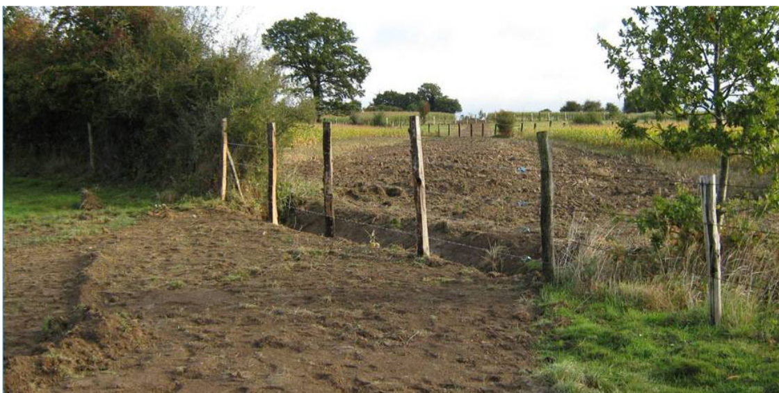
Photo D.6 : Aménagement d'une clôture
