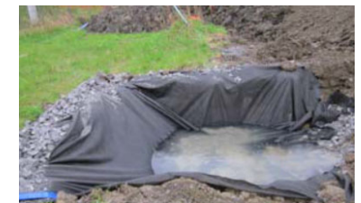
Photo F.15 : Trappe à sédiments avec berme étanche
