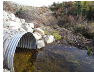
Photo F.5 : Reconstitution d'un tapis végétal (mousse), projet de raccordement du complexe de la Romaine
