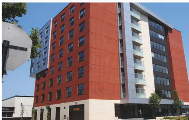
7001, avenue du Parc
