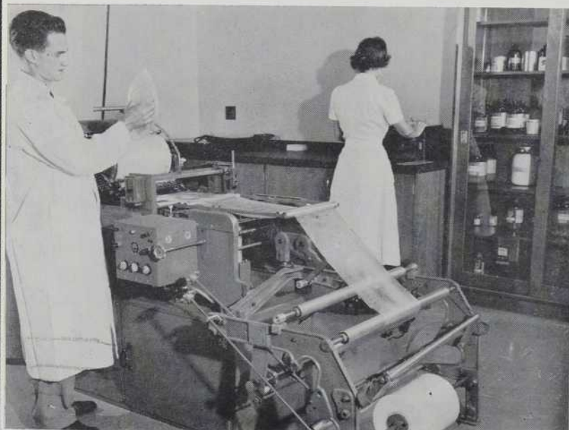
CETTE MACHINE A FABRIQUER LES SACS DE POLYTHÈNE EST SEMBLABLE A CELES DONT SE SERVENT LES FABRICANTS DE SACS. ELLE PERMET D'EPROUVER A L'USAGE LES CARACTERISTIQUES DES PELLICULES ET DE S'ASSURER QU'ELLES RESPONDENT AUX EXIGENCES DE CES FABRICANTS AU POINT DE VUE DE LA QUALITE.
