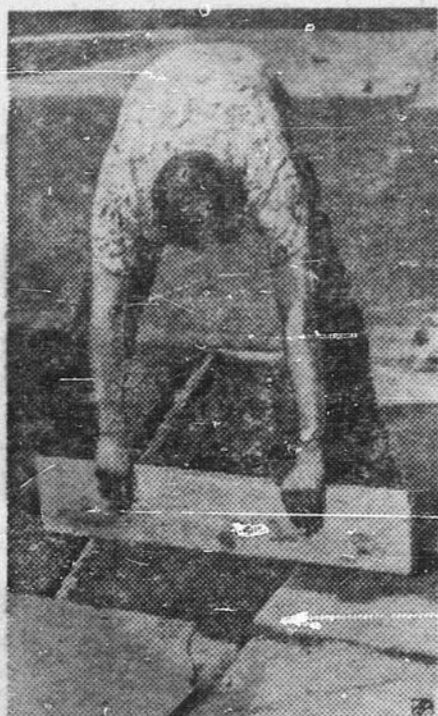
Il faut niveler le tas de ciment à l'aide d'une planche...
