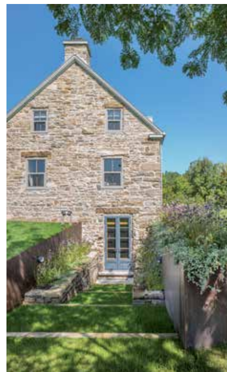
L'accès au sous-sol a été réaménagé avec de nouveaux murs de soutènement en acier Corten.
