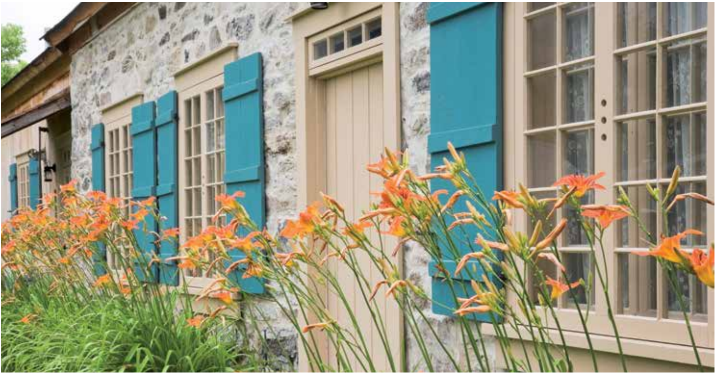
La peinture s'avère la meilleure option pour protéger le bois à l'extérieur, notamment parce qu'elle forme un écran contre les rayons ultraviolets. Photo : Perry Mastrovito
