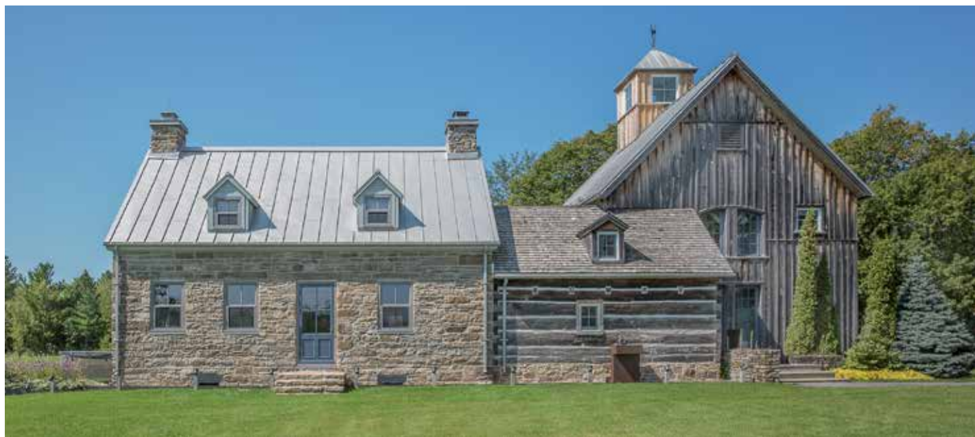
Ensemble de la maison de ferme intégrant la maison ancestrale en pierre des champs, le corps bâti en pièce sur pièce et l'ajout avec son revêtement de planches à couvre-joint.
