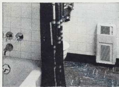
SALLE DE BAIN avec appareil de 6,000 BTU de capacité. Ces appareils à modulation automatique ne requièrent aucune connexion électrique.
