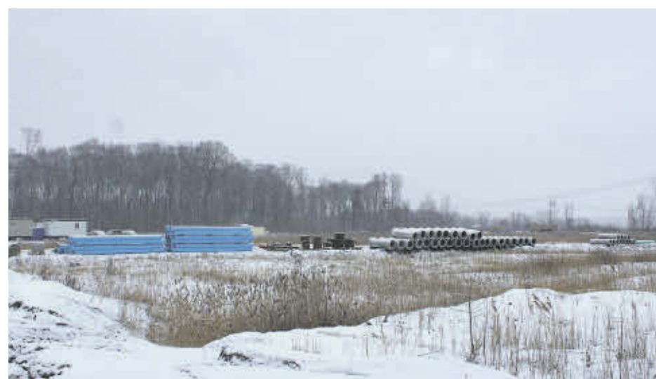
Des travaux d'infrastructures ont actuellement lieu sur le site de la Cité 3000 pour accueillir les futures entreprises. Photo Ville de Contrecoeur
