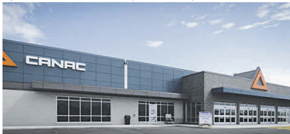
Le CANAC de Contrecoeur totalisera 43 000 pieds carrés de superficie et comptera un entrepôt de 31 000 pieds carrés Photo gracieuseté
