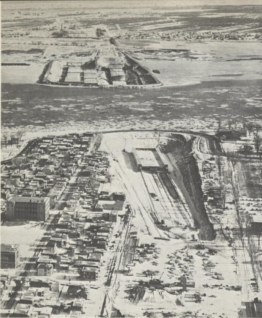
A l'avant-plan, encore à découvert, la partie nord du tunnel Lafontaine que contourne, du côté du fleuve, le chemin de détour de la rue Notre-Dame. A l'arrière-plan, la cale sèche où l'on aperçoit, à droite, la continuation du tunnel et, à gauche, les sections qui seront trainées dans le fleuve et immergées bout à bout entre les longueurs déjà construites du tunnel.
