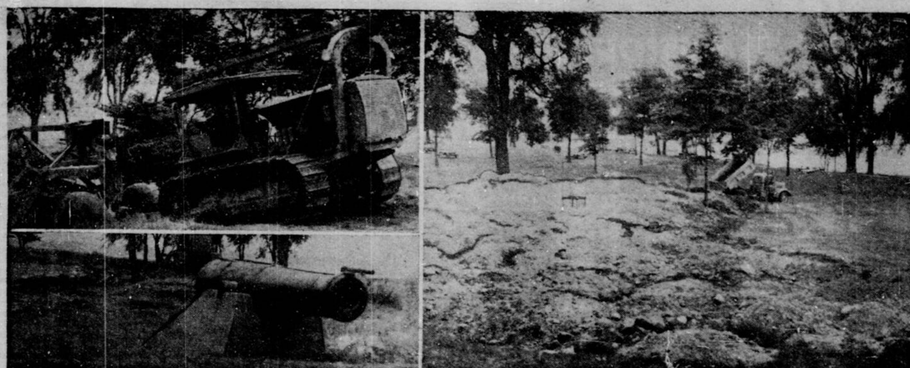
Les travaux en vue de l'aménagement de l'île Sainte-Hélène, pour en faire un lieu de repos, à la portée des masses, sont commencés, bien qu'ils aillent encore au petit train. On y fait actuellement du terrassement, enlevant de la terre de certains endroits et en ajoutant
