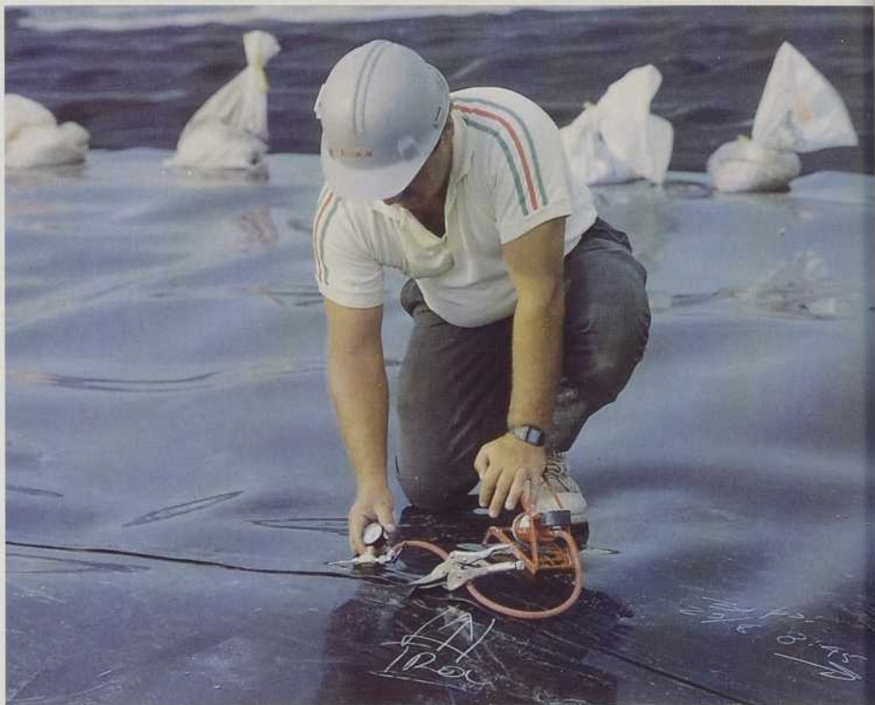
Après la pose de la géomembrane, on vérifie les joints centimètre par centimètre.
