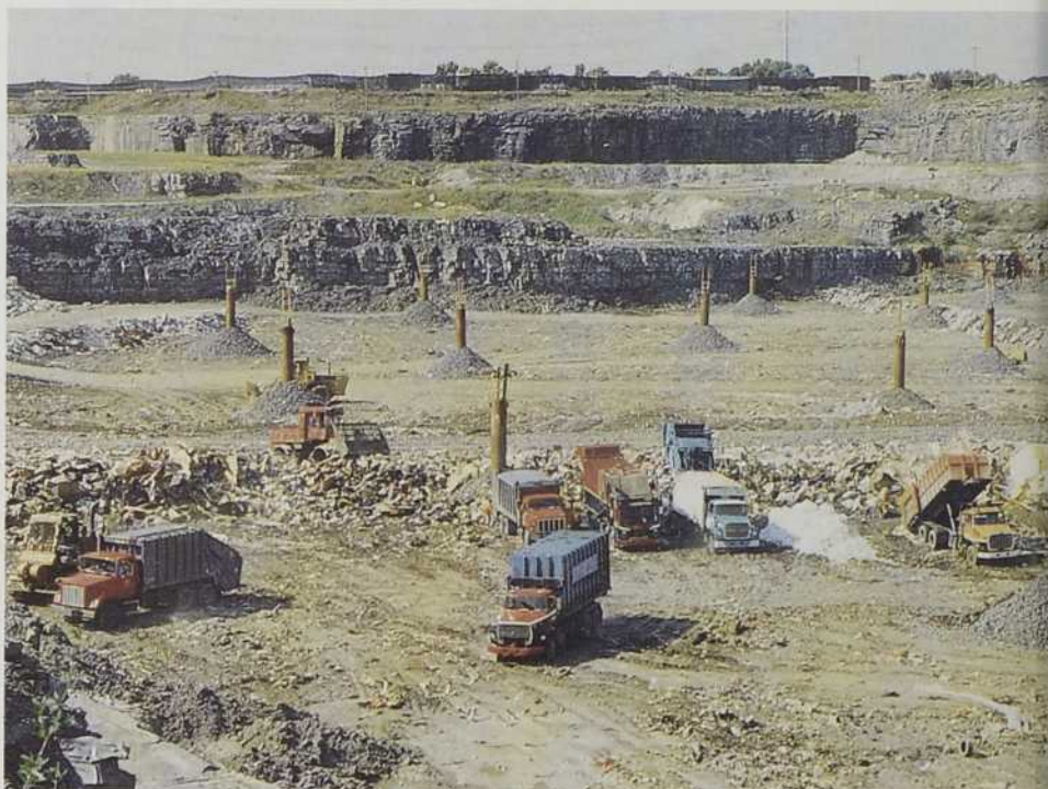
Chaque jour, les déchets sont recouverts de terre dans le dépotoir de l'ancienne Carrière Miron. Les camions vident leur benne dans un périmètre bien précis.
