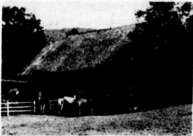
Bâtiment pièce-sur-pièce encore bien conservé sur la ferme de M. Lauzon.
