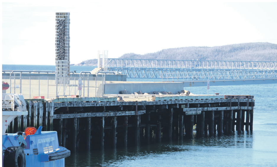
Les travaux au quai Mgr-Blanche impliquent de démolir la portion du quai en bois.
