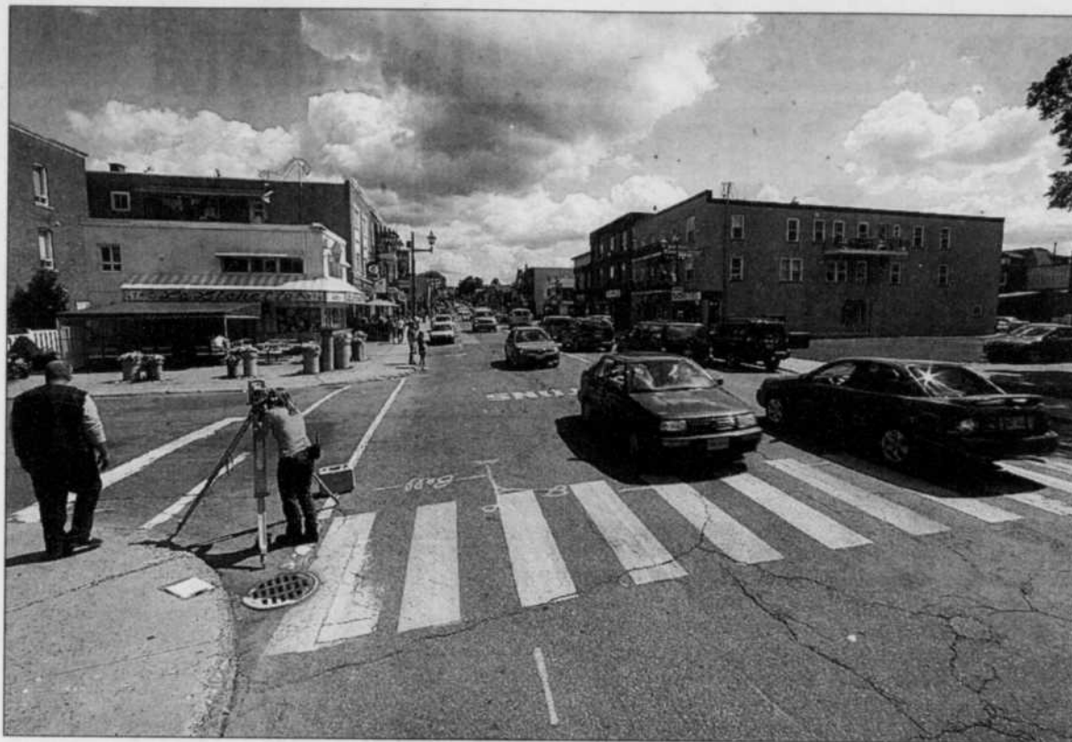
Le réaménagement des traverses piétonnières à l'intersection de la rue Principale et des rues Gill et Brébeuf à Granby devrait débuter lundi.
