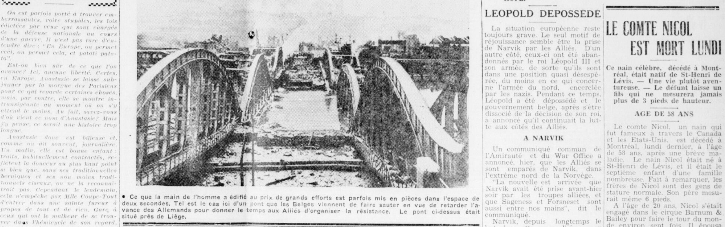
• Ce que la main de l'homme a édifié au prix de grands efforts est parfois mis en pièces dans l'espace de deux secondes. Tel est le cas ici d'un pont que les Belges viennent de faire sauter en vue de retarder l'avance des Allemands pour donner le temps aux Alliés d'organiser la résistance. Le pont ci-dessus était situé près de Liège.
