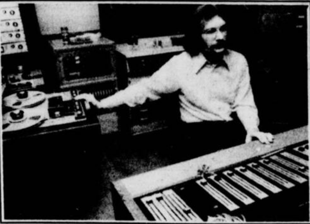
Une fois le nettoyage complété, le technicien passe à la console où il lui sera possible d'apprêter les sons destinés à être gravés sur une matrice après avoir été enregistrés sur ruban magnétique.
