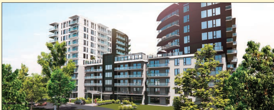
La Société immobilière Huot vient d'annoncer son plus récent projet, La Consolata, un projet évalué à 70 M$, dont la construction est entamée depuis quelques mois sur le terrain de l'ancien campus du Séminaire Saint-Augustin.
