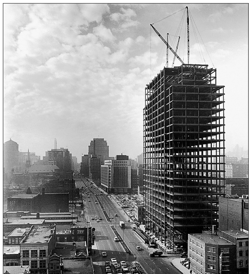
PHOTO FOURNIE PAR HYDRO-QUÉBEC
