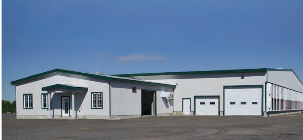
La pente du toit de l'étable est inversée par rapport à l'orientation habituelle. Mathieu Larose juge que cela offrira plus de flexibilité, dans le cas d'un agrandissement. La structure est entièrement métallique. Tous les matériaux ont été choisis de façon à rendre le bâtiment ignifuge.
