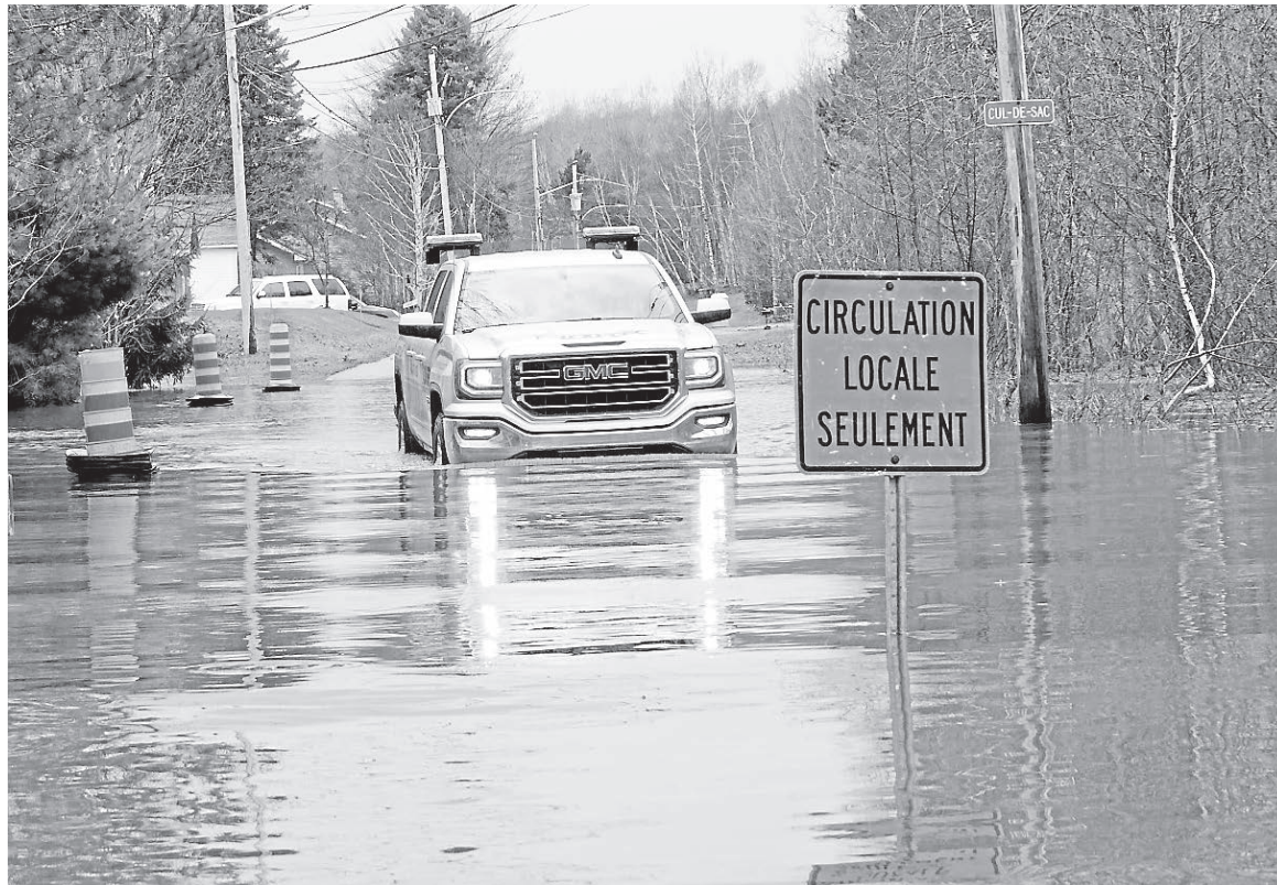
L'eau s'est invitée à nouveau sur l'avenue du Beau-Rivage, forçant des résidents à laisser leur voiture sur le chemin des Bois-Francis avant d'être transportés par des employés du service des travaux publics de la Ville de Shawinigan.
