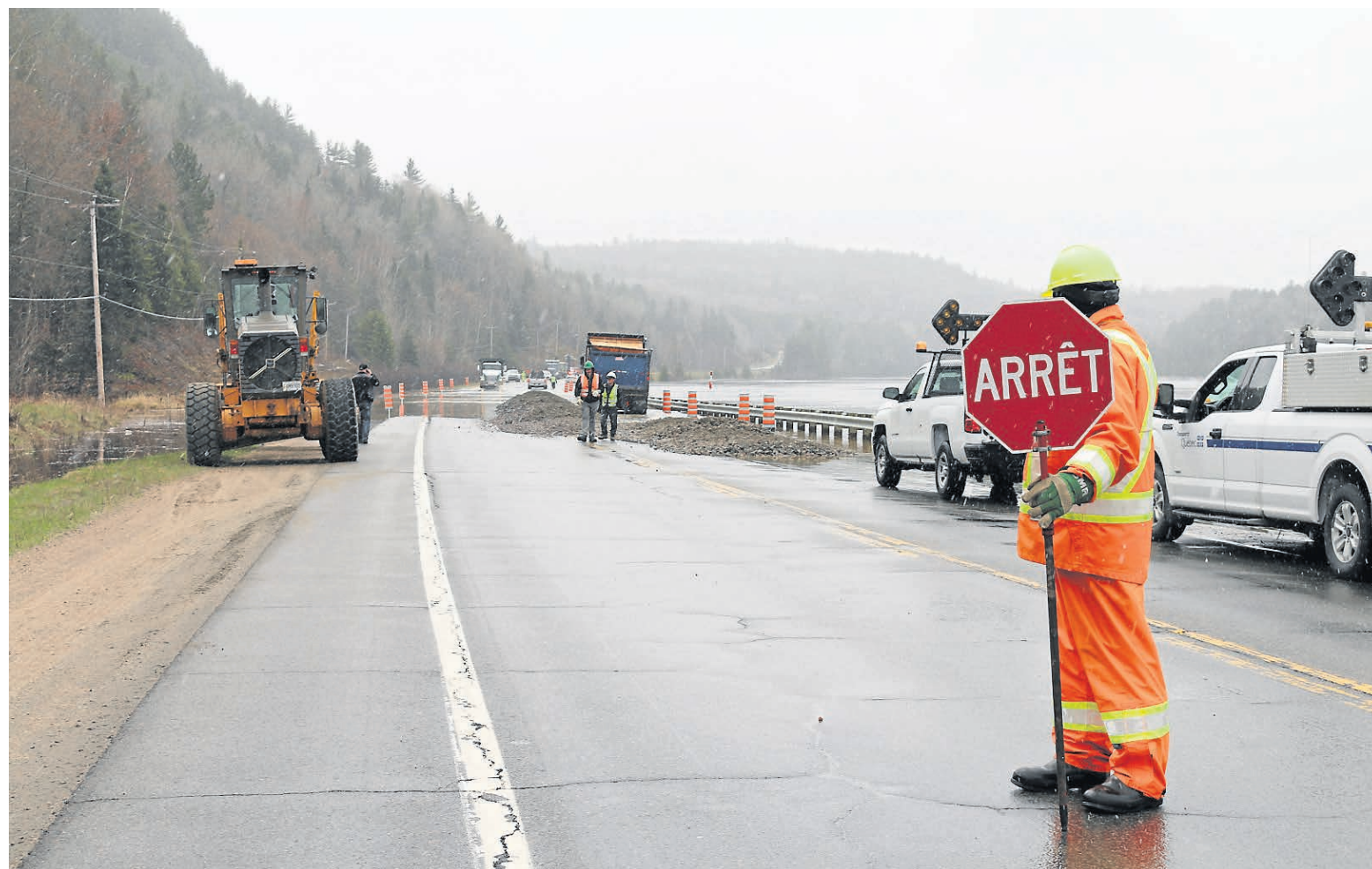
Les travaux de rehaussement d'une portion de la route 155 se sont déroulés lundi. — PHOTO: AUDREY TREMBLAY
