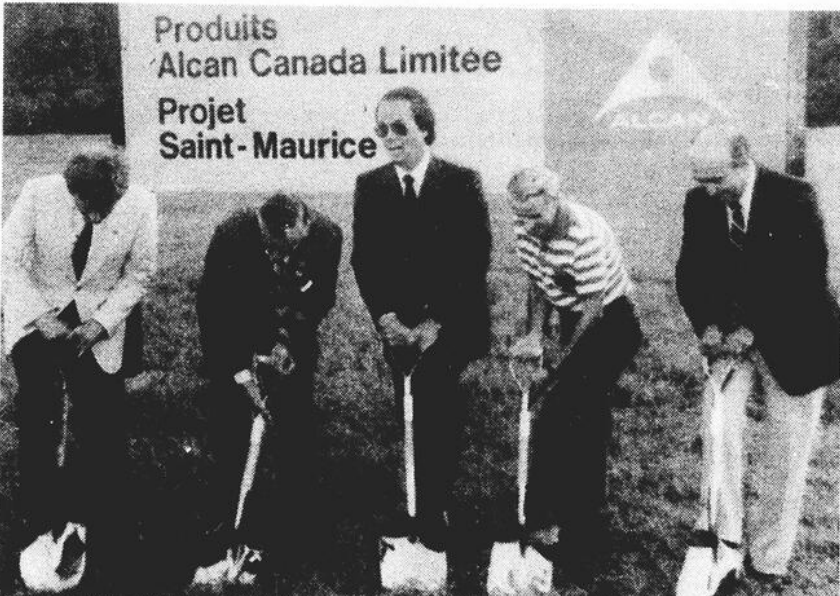
Un moment historique qui restera gravé longtemps dans la mémoire des gens: la première pelletée de terre de la future usine Saint-Maurice qui sera mise en opération d'ici à 1986. Sur la photo: le maire Dominique Grenier, M. Stanford Treat, président de Produits Alcan, le ministre Yves Duhaime, M. Maurice Charette, de la compagnie et M. Marcel Bérard, représentant du ministre Jean Chrétien. (Photo L'HEBDO Sylvain Aubry).
