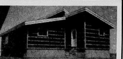
POUR $15,000 , au Mont-Comi, rang des 7 lacs, bungalow en construction de 55x30 sur terrain 100x125. Michèle Blanchette, 722-8267, Inter-Cité Courtier, 722-7695.
