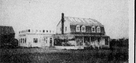
PTE-AU-PÈRE , cottage vue sur la mer et hôtel licencié, très bonne renommée, chiffre d'affaires intéressant. Georges Gendreau, 724-6130, Inter-Cité Courtier, 722-7695.
