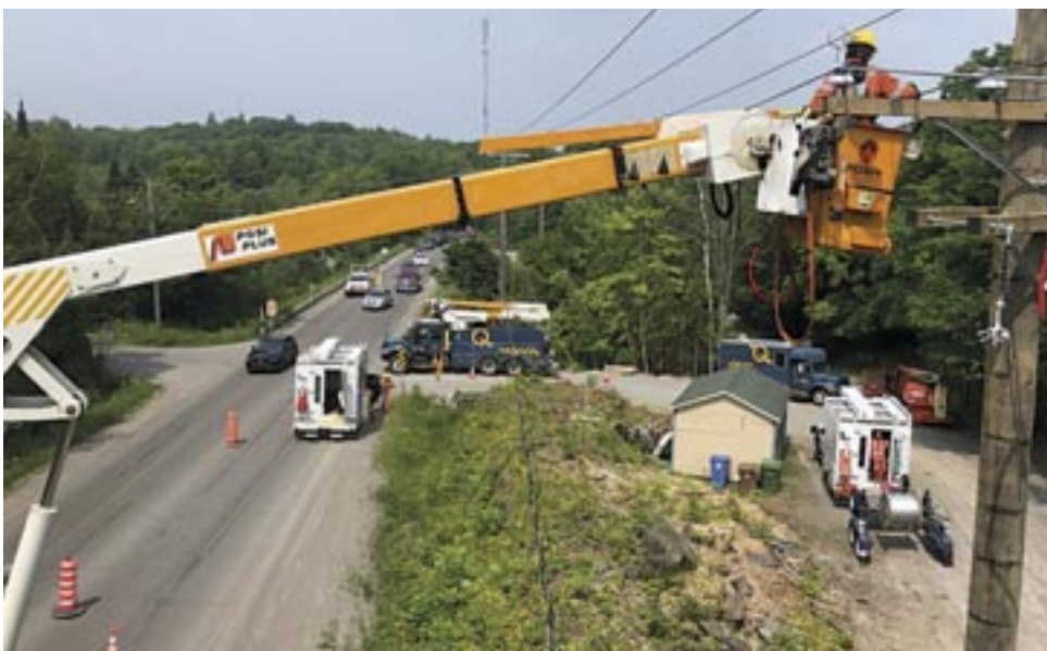
Hydro-Québec à l'œuvre, le 9 juillet 2019, à l'intersection du chemin des Hauteurs et de la rue Simard.
