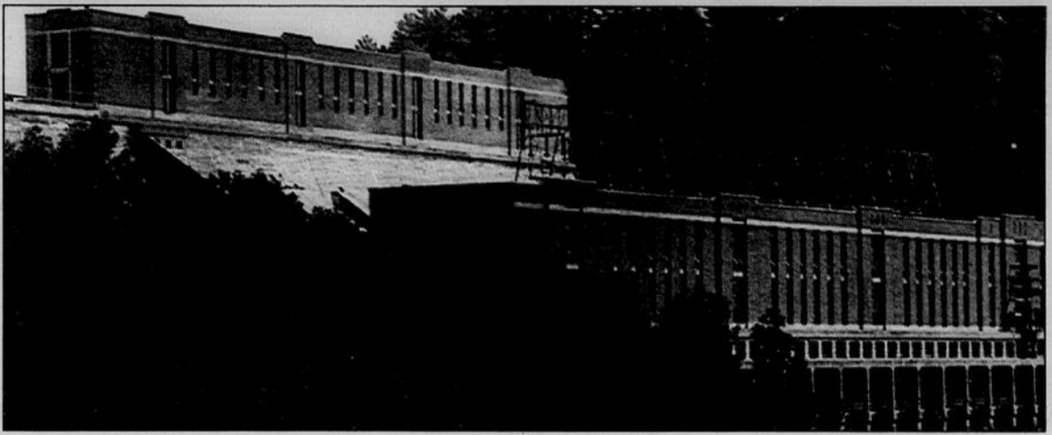
Le barrage hydro-électrique Paugan
