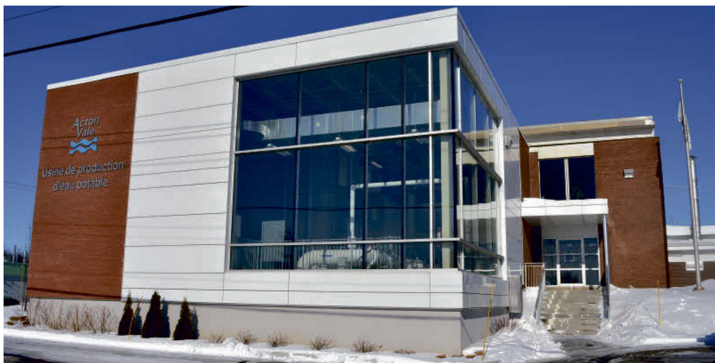
L'usine de traitement des eaux d'Acton Vale a subi des travaux de mise aux normes majeurs, avec des investissements totaux d'environ 4,4 millions $.
