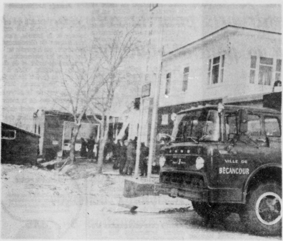
La rapide intervention des pompiers de la ville de Bécancour a eu vite fait de mettre sous contrôle l'incendie qui faisait rage, hier matin à l'épicerie de M. Jean-Guy Lavigne de Sainte-Marie-de-Blandford. Les flammes s'étaient déclarées dans un entrepôt à l'arrière du ma-
