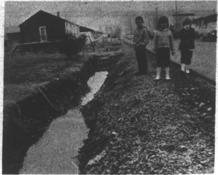
Un des signataires de la requête nous a indiqué ce fossé qu'on n'a pas devant un terrain parce que, affirme-t-il, le propriétaire de ce terrain serait un ami des administrateurs municipaux qui n'ont pas voulu qu'on endommage le terrain en question.
