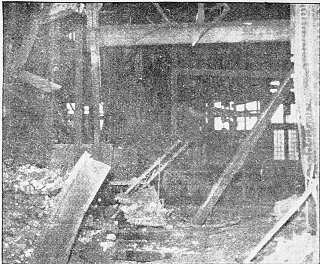
Cette photo représente l'intérieur de l'établissement Farand & Delorme Ltée, réparateurs de bouilloires, à 385 rue St-Martin, qui a été ravagé par l'explosion d'un récipient de gaz acétylène, hier après-midi.—Voir nouvelle en page 5—(Photo "L'Illustration Nouvelle").
