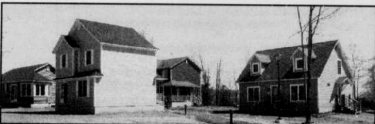
En bordure de l'autoroute 10, Les Maisons Alouette propose neuf modèles de maisons préfabriquées aux visiteurs.
