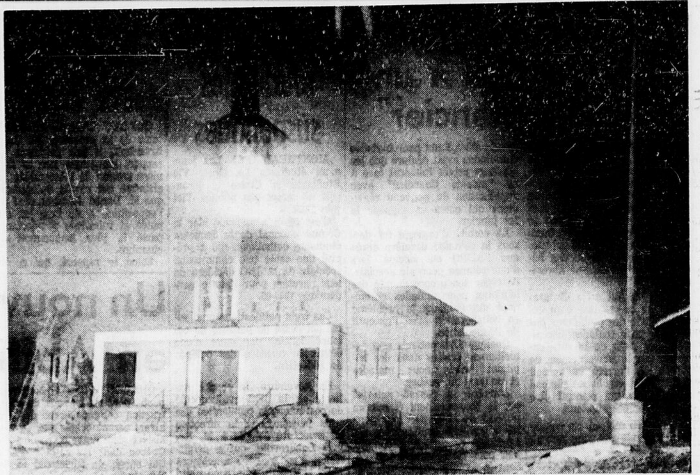
L'ÉGLISE DU COEUR-IMMACULÉ-DE-MARIE, de Mont-Laurier, a été la proie des flammes durant la nuit de mardi à mercredi. Tout l'intérieur de l'édifice, de même que le toit ont été brûlés. Les poutres en forme d'arche qui soutenaient le toit, les murs en pierre et le clocher sont demeurés
