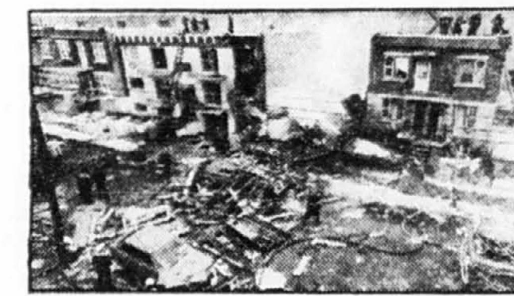
L'explosion qui a littéralement fait éclater une maison unifamiliale rue de Lanaudière, avait été provoquée par une défectuosité du système de gaz naturel.
