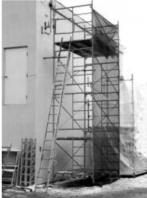
Figure 4 - Échafaudage sur cadre métallique utilisé avec un filet
