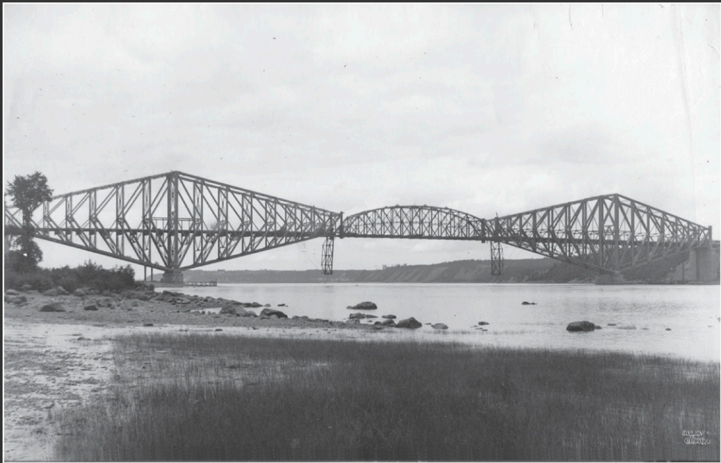
Construction du pont de Québec, 1916. BAnQ Québec, fonds J. E. Livernois (P560, S2, P300390).
