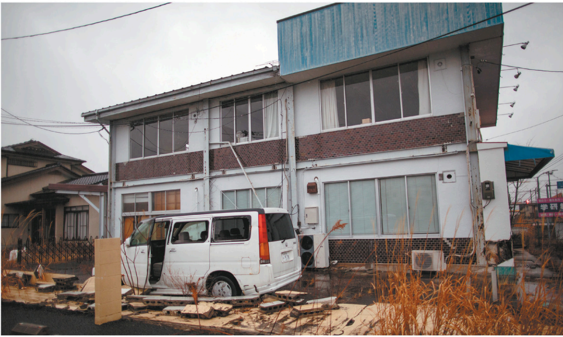
Nissan a inauguré cette semaine une usine à Namie. Dans cette ville ravagée par le tsunami du 11 mars 2011, 80% du territoire reste interdit d'accès.
