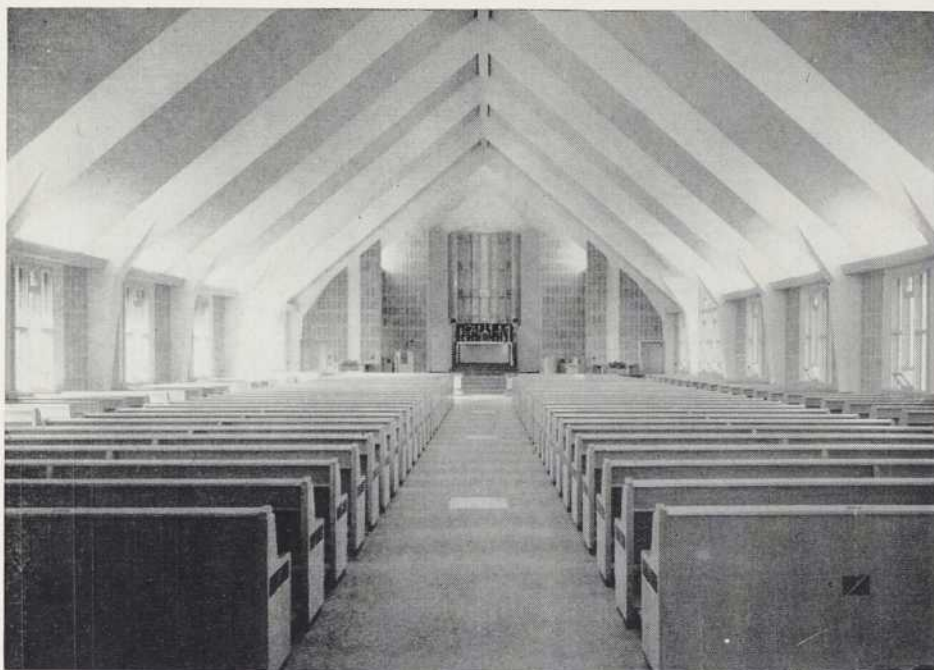
Ci-contre. La nef vue de l'entrée. Parquet de terrazzo, murs en blocs de perlite. Aucune peinture, aucun fini surajouté, le matériau étant partout laissé à nu.
