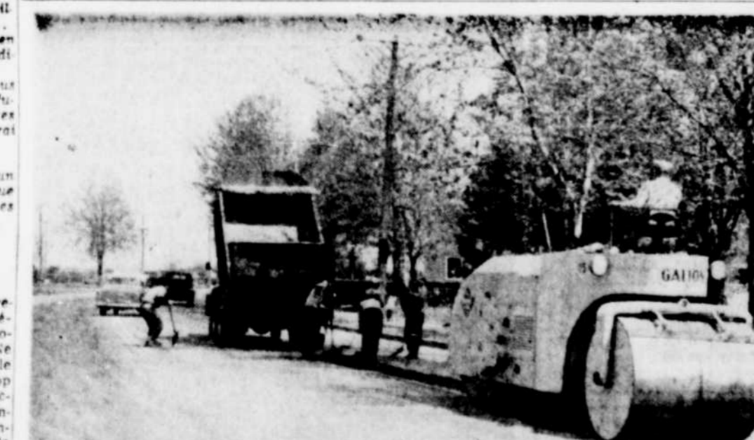
LES PETITS TROUS DEVIENDRONT grands, avant longtemps, si on ne les remplit pas entre-temps. La Palice n'aurait jamais trouvé mieux. La citha à remplir sa promesse de faire réparer les rues avérées par le froid de la réouverture de l'usine d'Asphalte. La Regional Asphalt s'est mise à l'oeuvre, lundi dernier, et poursuit, au nom de la ville, une oeuvre salutaire pour les automobilistes, à pour $4, automobilistes.
