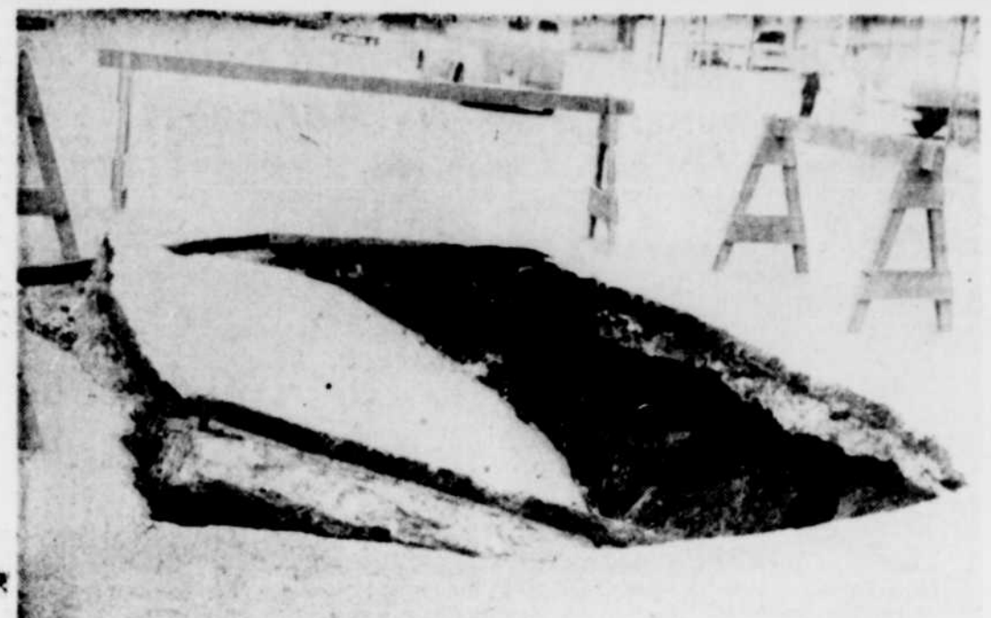
UN IMMENSE TROU s'est formé au milieu de la 4e rue, hier après-midi. Le sous-sol a été miné, soit par les eaux de la fonte des neiges, soit par les rats d'égout, à moins que l'on trouve une autre cause.
