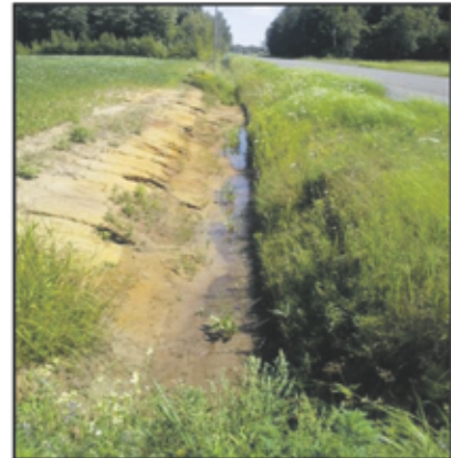
Cours d'eau ayant l'apparence d'un fossé et empruntant un fossé de voie publique
