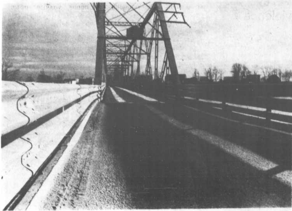
L'ENTREE NORD DE L'ANCIEN PONT DE TERREBONNE, inauguré en 1907, il continue à desservir une grande partie de la population de la région. Toutefois, si le gouvernement du Québec ne veut pas contribuer financièrement à son entretien, la Ville de Terrebonne le fermera pour assurer la sécurité publique.
