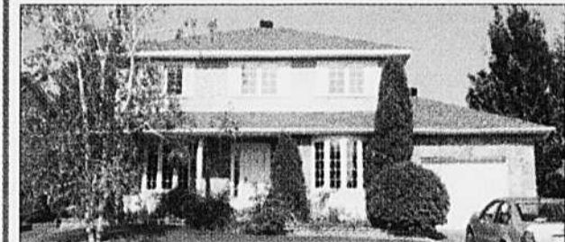
BOUCHERVILLE , spacieuse et invitante propriété au coeur de La Seigneurie, 3 CAC, planchers de lattes, très belle cour intime avec piscine creusée. IMPECCABLE! À voir!
