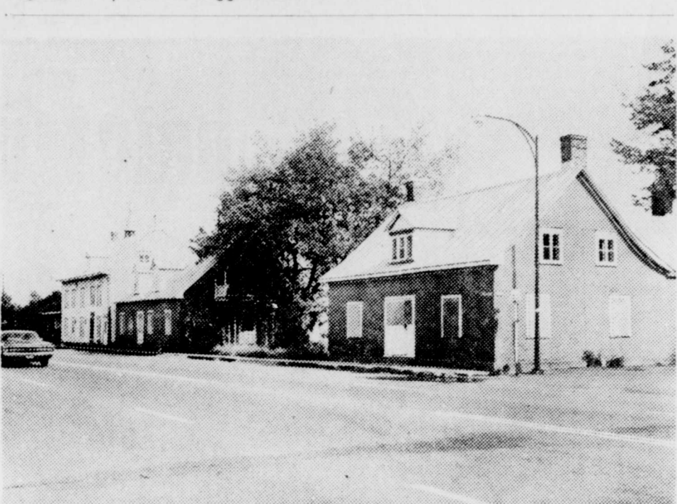
Cet édifice de deux étages où loge présentement la Sûreté du Québec, détachement de Nicolet, pourrait éventuellement être transformé de façon à recevoir les bureaux administratifs de la ville. L'immeuble appartient à M. Laurent P. Leblanc et à un peu plus de trois ans d'existence. Le conseil municipal pourrait par la suite, après en avoir pris possession, se porter acquéreur d'un immense terrain avoisinant et éventuellement construire un garage pour recevoir le service de protection contre incendie. Le coût global du projet serait d'environ $130,000, selon les informations obtenues d'un membre du conseil municipal. (Photo Pierre Wibaut)
