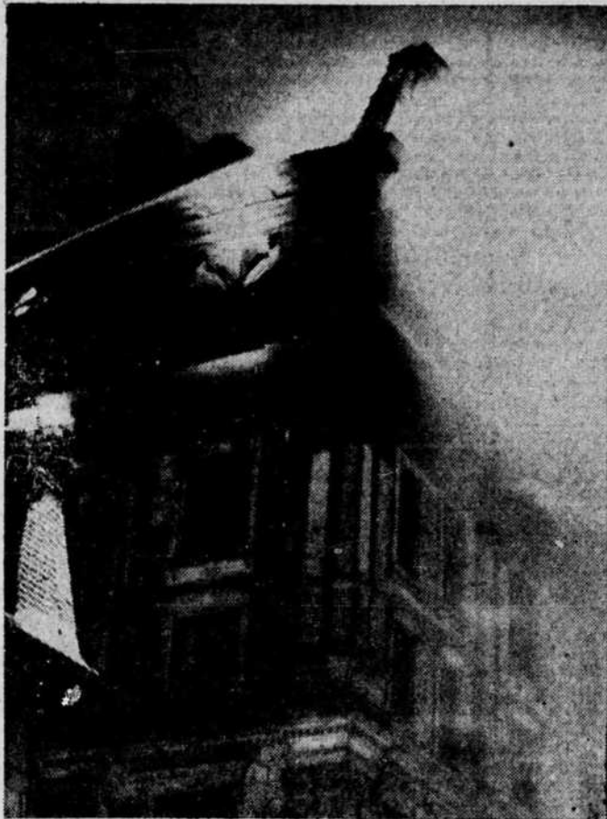
La cheminée devait s'effondrer quelques instants plus tard.
