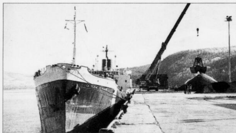
Le projet consiste en la construction d'une desserte ferroviaire de 12,5 kilomètres à 4 millions $ du kilomètre et des autres installations pour la manutention de la marchandise du terminal situé sur le plateau.
