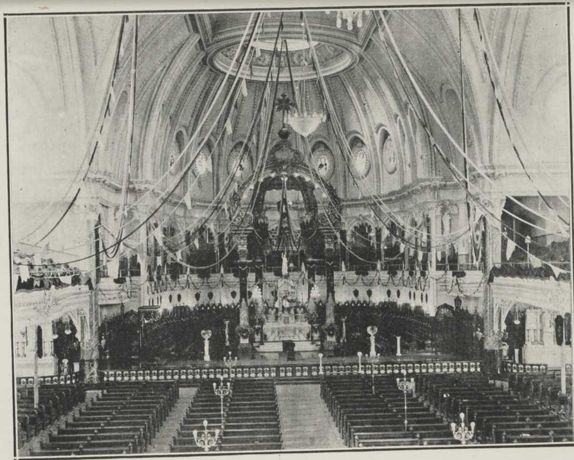
L'intérieur de la troisième église (1915)
