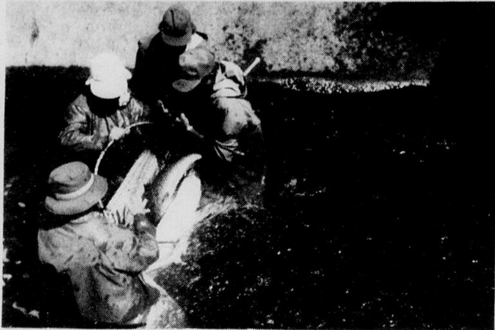
C'est au pied du barrage de Mitis 11 que les spécialistes en aménagement de la faune procédaient à l'opération de capture permettant la survie de 236 saumons. On voit ici le bassin de "dissipation d'énergie" et le système de câbles et de poulies utilisés pour hisser les saumons capturés.
