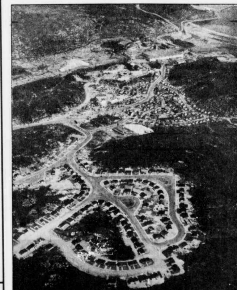
Le sommet économique de la Côte-Nord avait eu lieu à Baie-Comeau, à l'automne 1988. Une vue générale de Baie-Comeau
