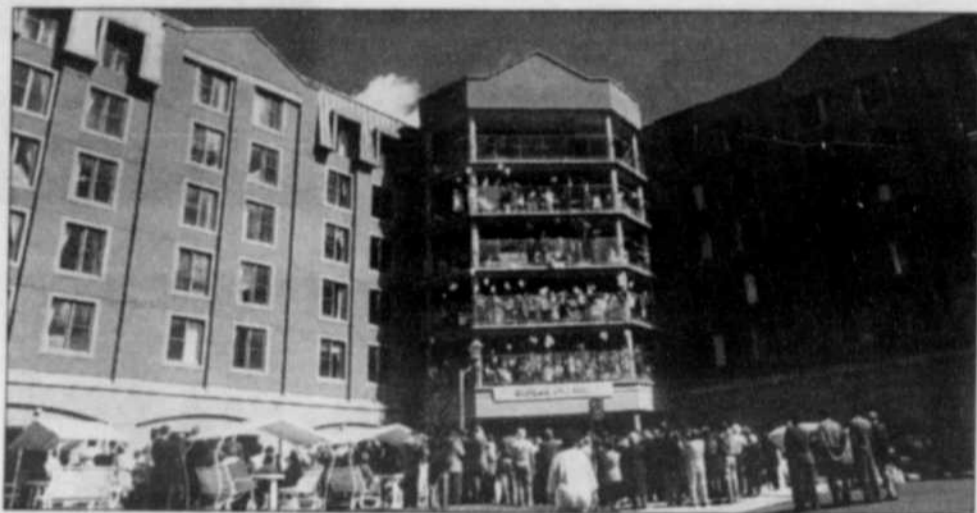
Plusieurs dizaines de convives ont participé à l'inauguration officielle du Centre d'accueil de L'Assomption. Ballons et banderoles étaient visibles sur les balcons de l'édifice.
